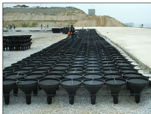
<사진-4> 용기판넬의 설치
