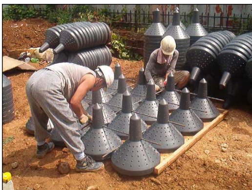
<사진-3> 팽이용기 판넬조립
