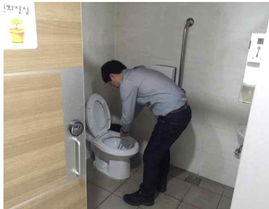
복지관 시설물 점검 및 보수
