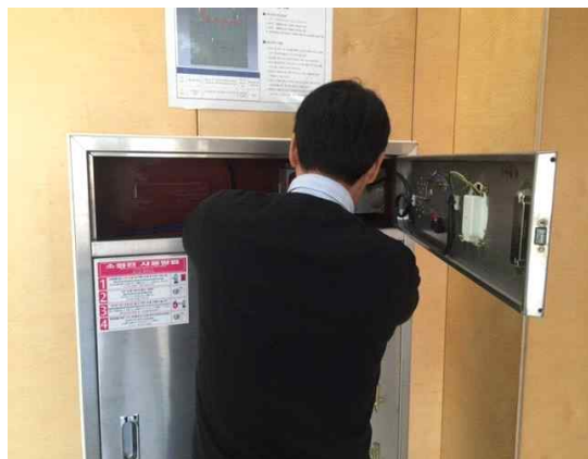
복지관 시설물 점검 및 보수
