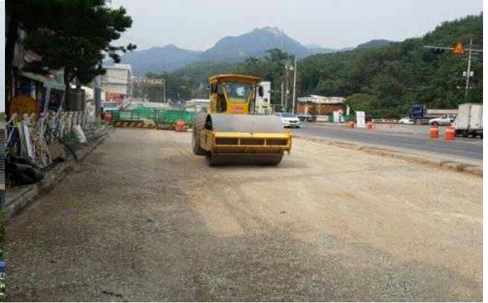
〈 개착구간 도로복구 공사 〉
