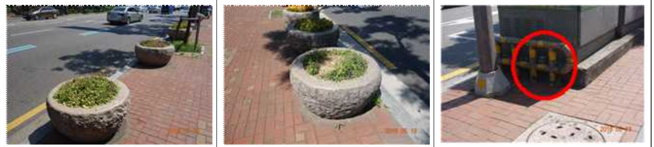
압구정로224 ~ 압구정로228 구간 내 돌화분 시들어감(5개)
