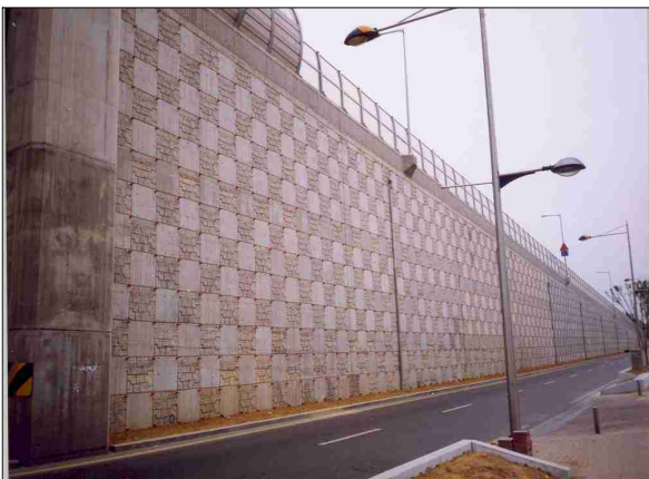
광진구 청담대교 진입로 옹벽(조성전)
