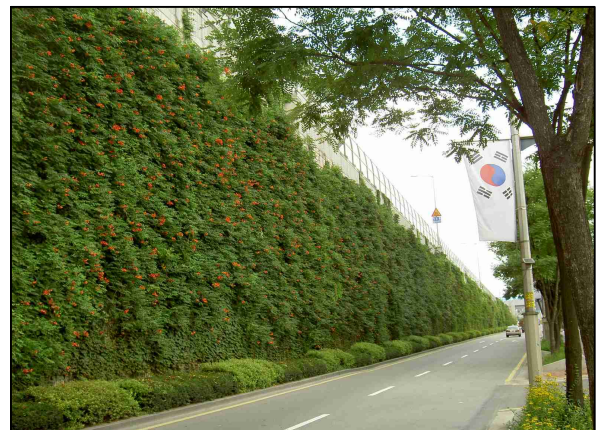
광진구 청담대교 진입로 옹벽(조성후)
