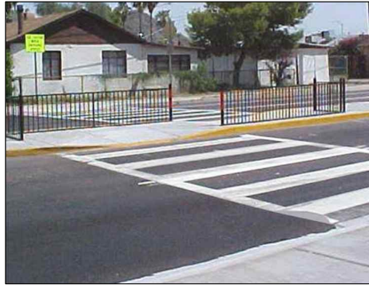
〈이단횡단보도에 안전펜스 설치〉
