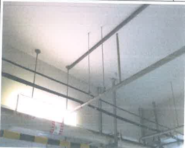
작업명 주차 차단봉 설치
