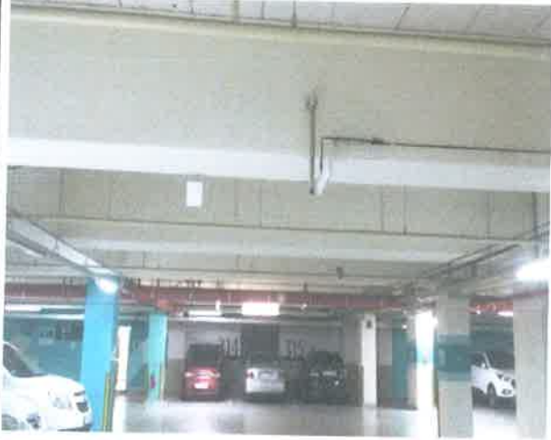
작업명 주차 차단봉 설치
