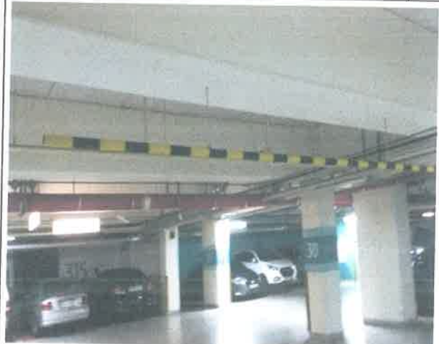
작업명 주차 차단봉 설치
