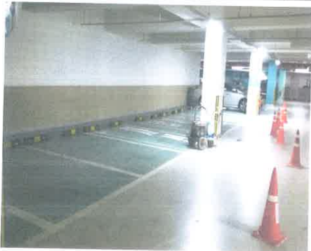
작업명 주차장 차선도색
