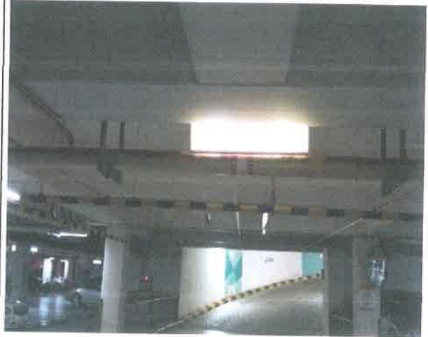
작업명 주차 차단봉 설치
