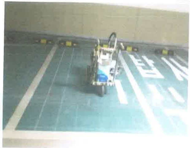
작업명 주차장 차선 도색
