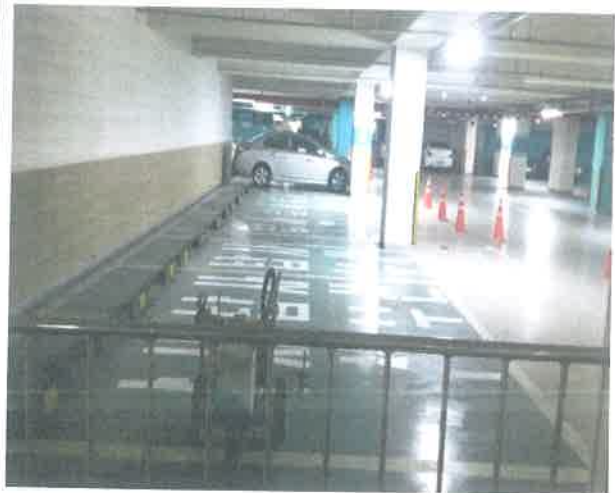
작업명 주차장 차선 도색
