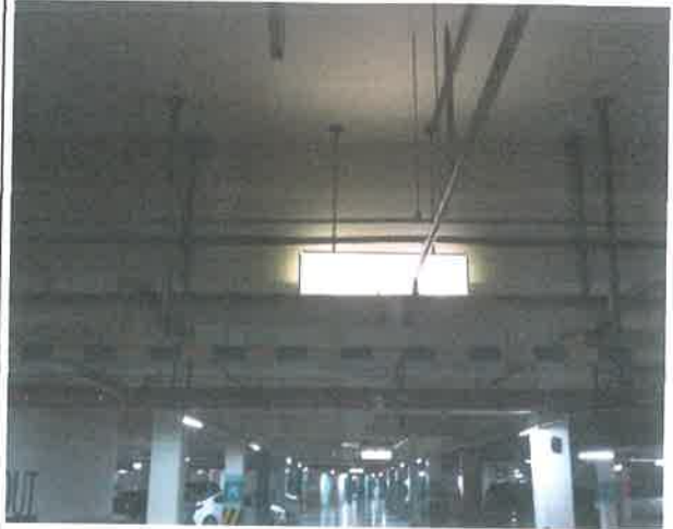
작업명 주차 차단봉 설치
