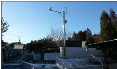
벽식 납골당 CCTV
