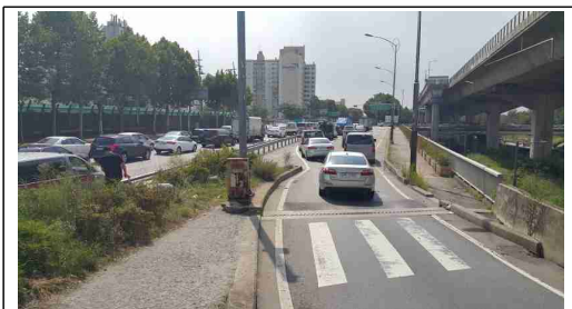
공사전 (내부순환로 성산램프)
