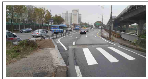
공사후 (내부순환로 성산램프)
