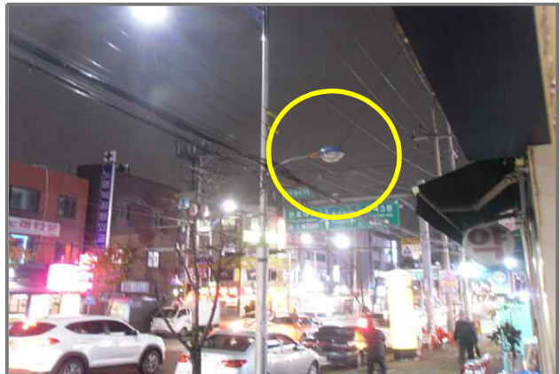
10 위치 긴고랑로 35 (중곡1동 241-24) 내용 가로등 부점등 (도로과)
