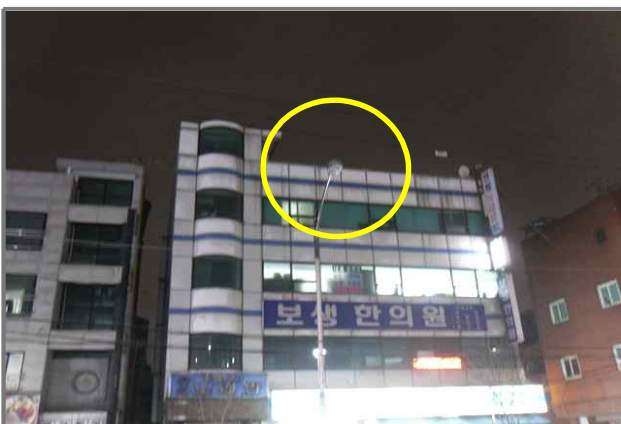
11 위치 긴고랑로 42-1 (중곡1동 242-1) 내용 가로등 부점등 (도로과)
