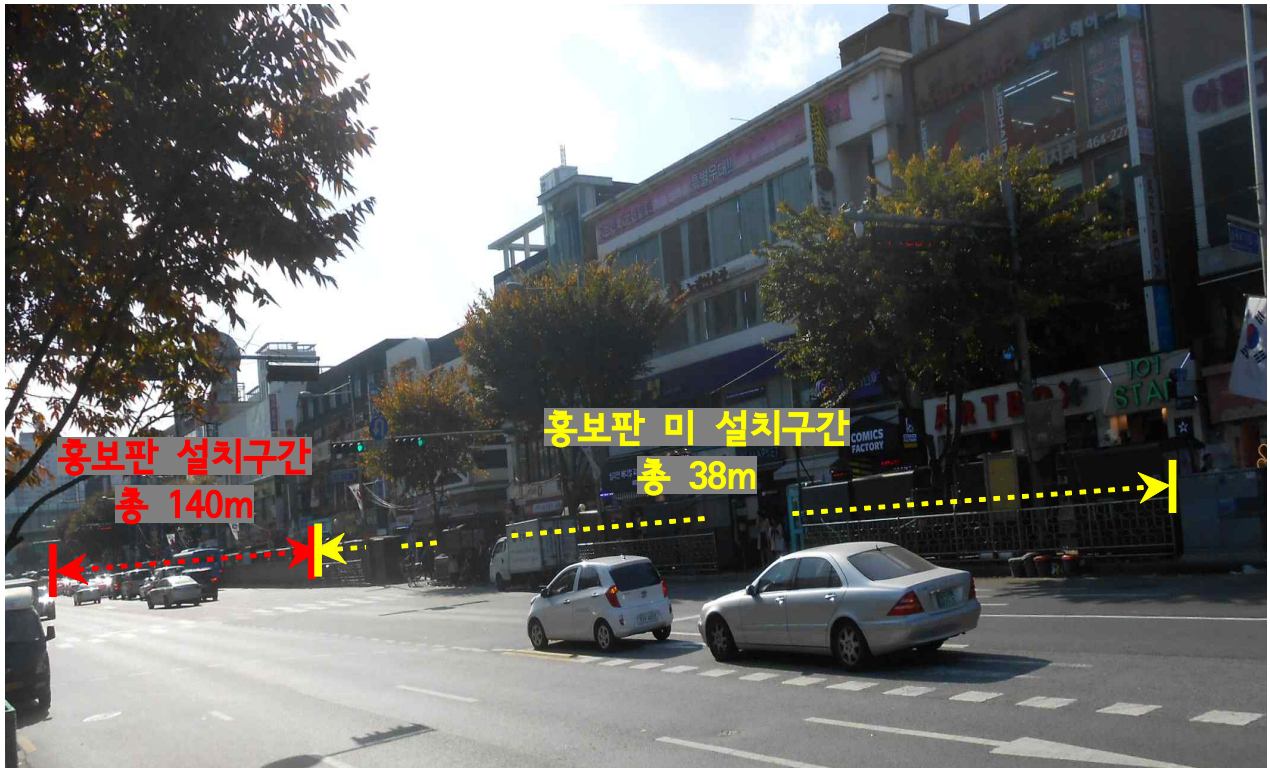
능동로 103 ~ 능동로 127 (가드펜스 설치구간)
