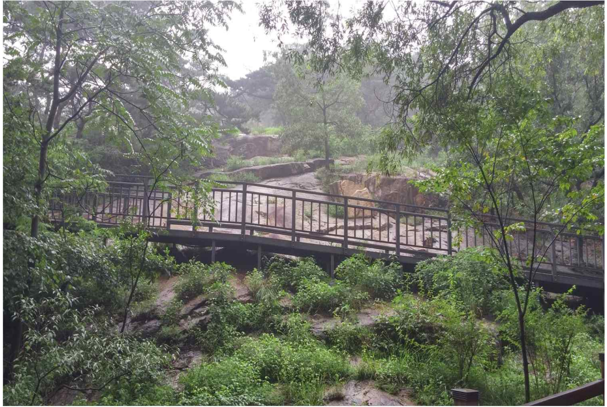
무장애길 구간 (폭포 설치 전)
