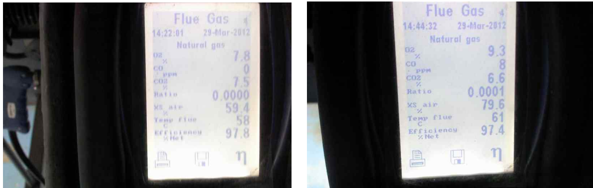
[그림1-2] 보일러 1,2호기 배가스 분석(O 2 농도) 측정사진
