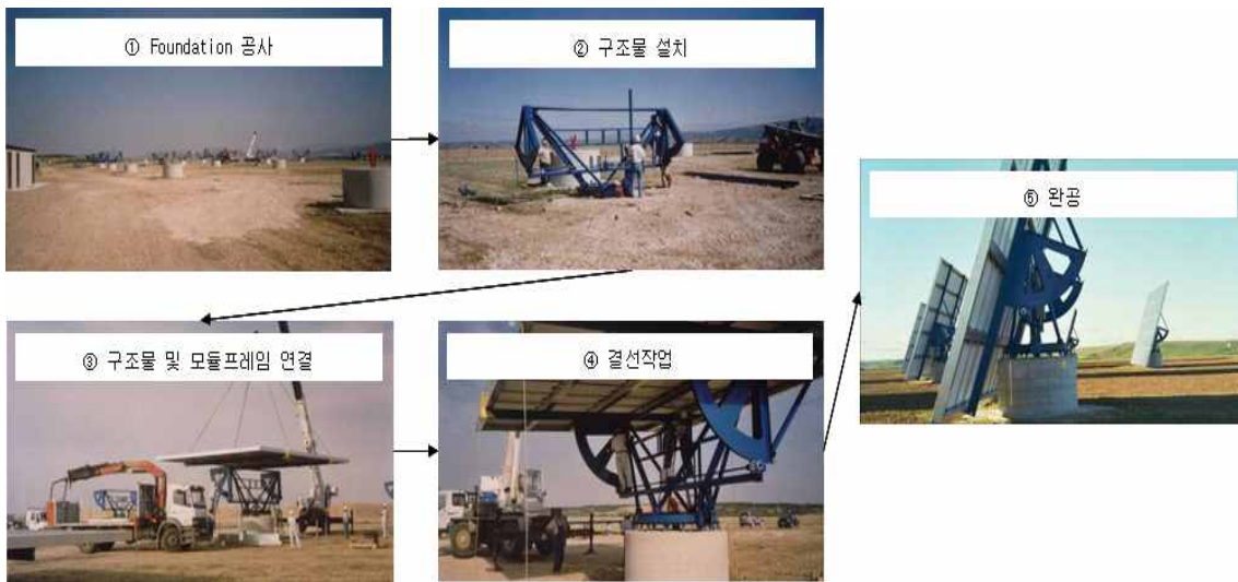
<SUNEVER MARX 트랙커 (15kWp) 설치 순서>
