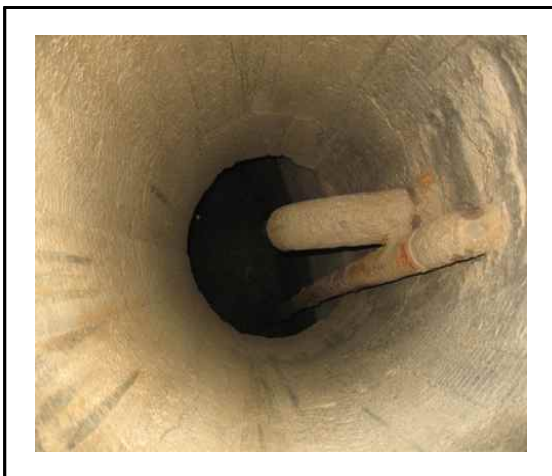
<사진3.2-1> 흡입관 투입구 토피(t=1.32m) 현황
