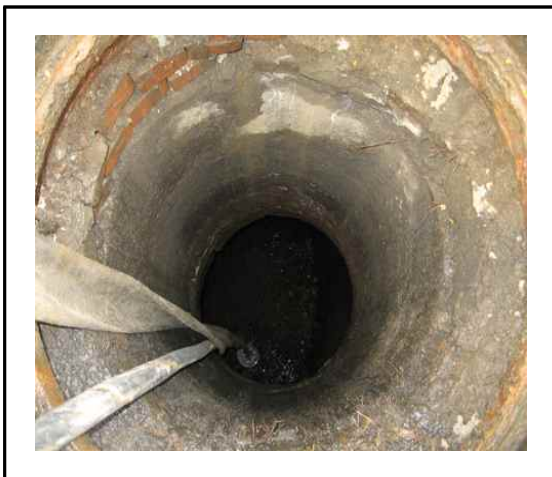
<사진3.2-1> 흡입관 투입구 토피(t=1.8m) 현황
