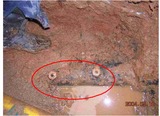
② 분수관 잠금 및 기존관 철거
