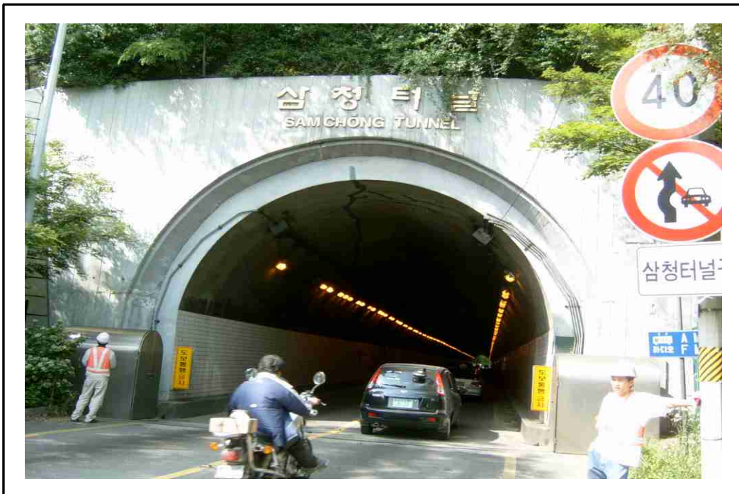
[사진 1.1] 삼청터널 전경
