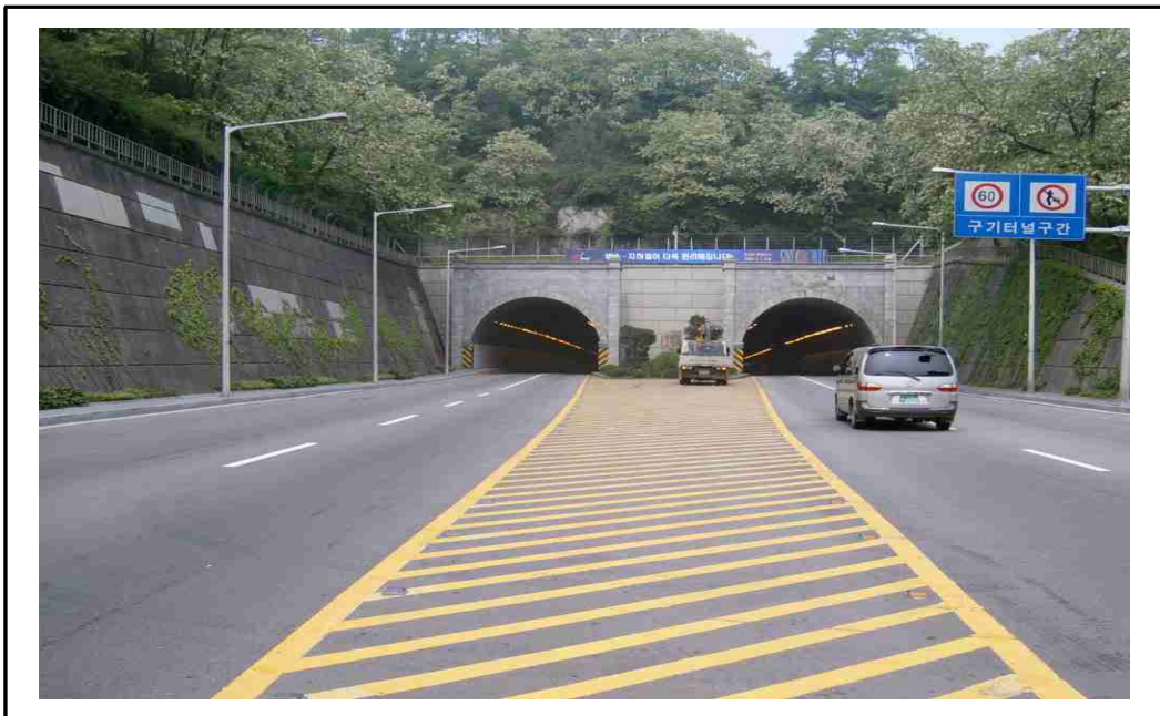
[사진 1.1] 구기터널 전경
