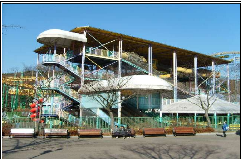
점검대상 건물 ⑤ (액션존)
