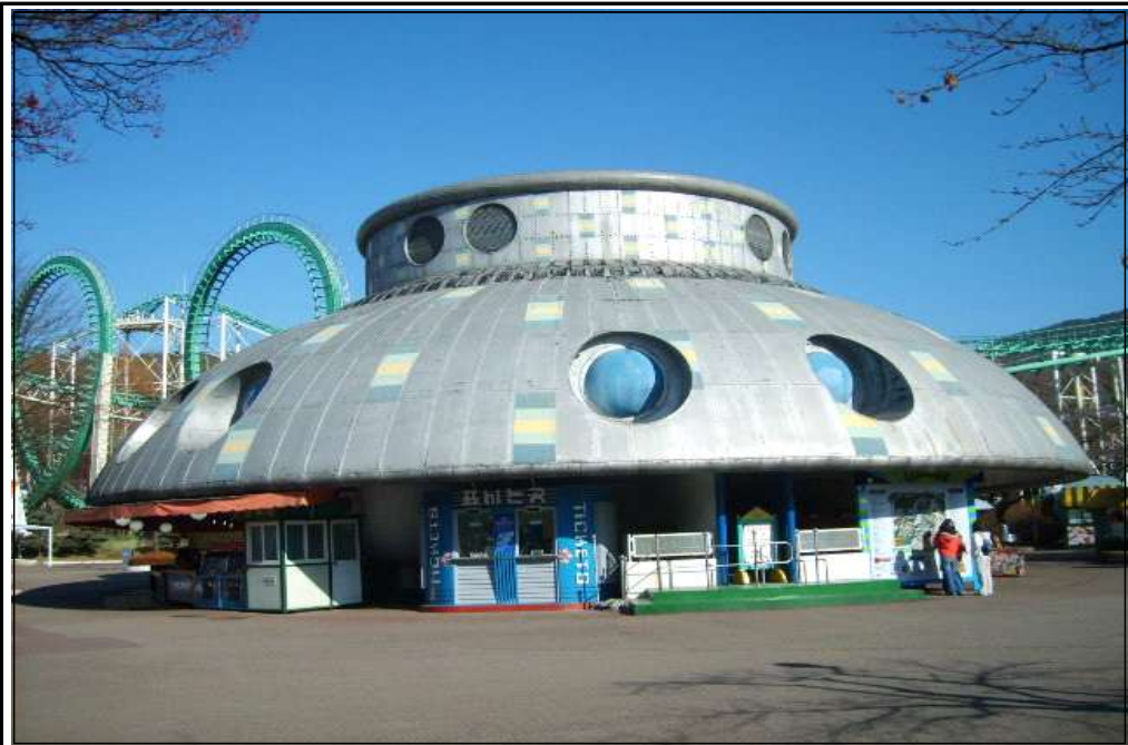
점검대상 건물 ③ (유에프오관)
