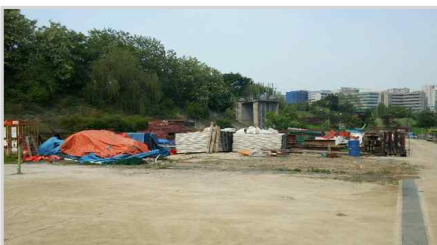
안전휀스 미 설치 (응봉동 둔치 족구장)
