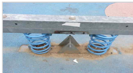
시소 고정판 파손 (무지개 어린이 공원)
