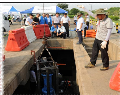
배수펌프 등 복구장비 설치
