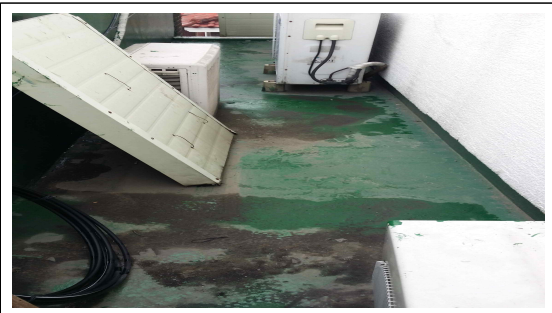
조치전 : (장위) 4층 난간 배수로 마확보
