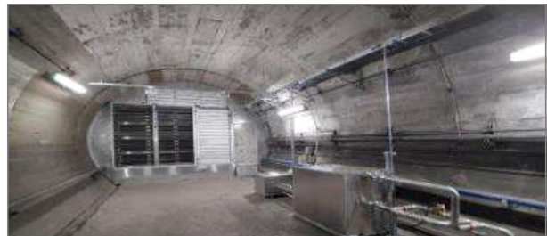
< 양방향 집진기 설치 >
