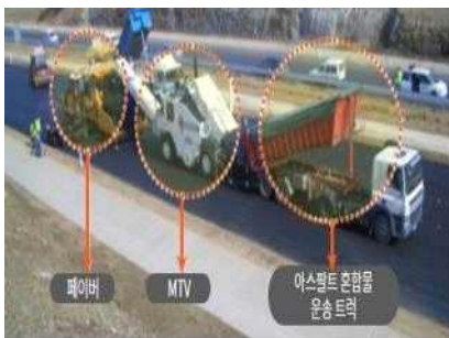
MTV를 활용한 시공
