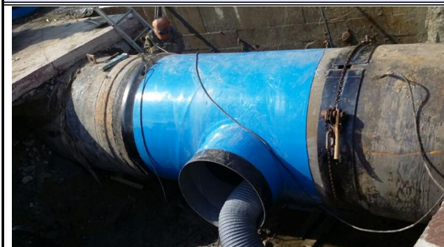
퇴수밸브 설치를 위한 정자관 설치
