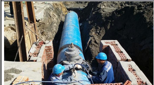
D900 퇴수밸브 설치
