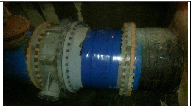
파손부위 복구 완료(플랜지 단관 접합)
