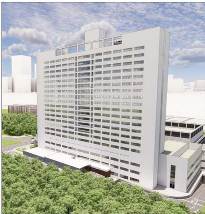
변경전 (1층 발열호흡기진료소)
