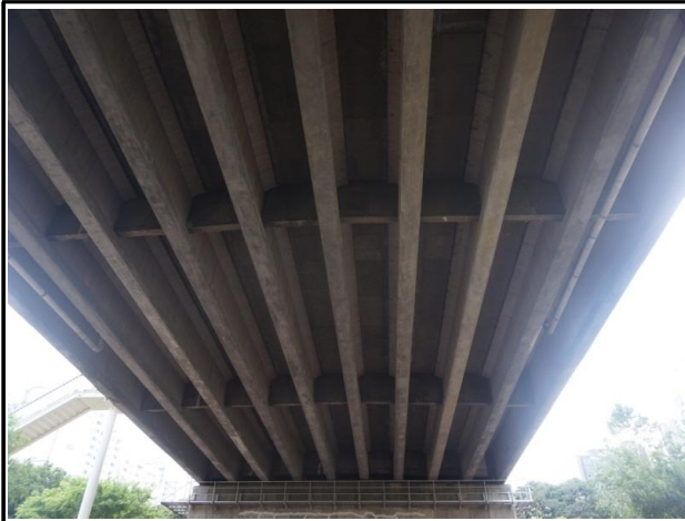
바닥판 및 거더 전경
