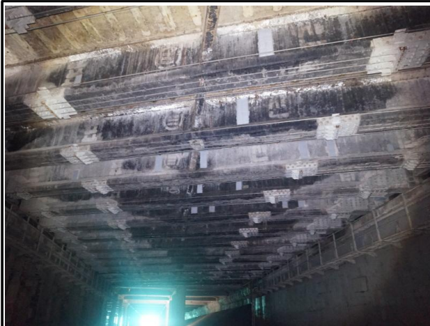
바닥판 및 거더 전경
