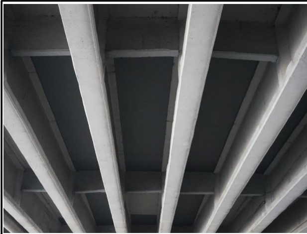
바닥판 및 거더 전경
