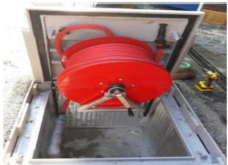
비상소화장치 설치(마장축산물시장)
