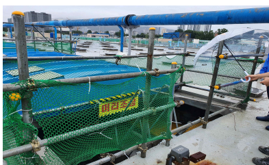
추락방지 안전난간대 설치 (개선)
