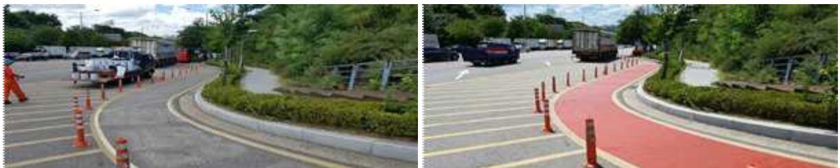
노후 자전거도로 포장 전·후
