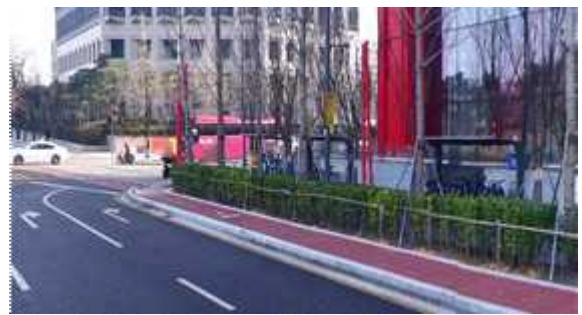
여의도 파크원 자전거도로 설치 후
