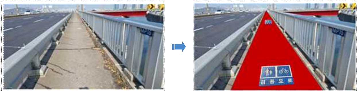
【한강교량(성수대교) 자전거도로 설치 전후 현황사진】
