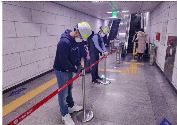
< 동선분리 펜스 설치(시청역) >
