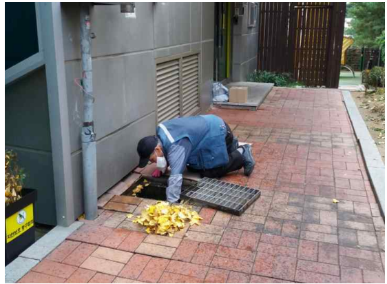
빗물받이 점검 및 청소
