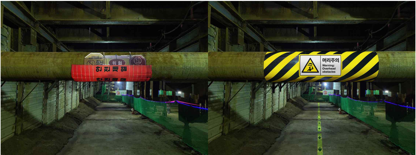
▲ 낮은 높이의 구조물에 충격흡수소재 내장 및 안전색을 적용한 머리주의 안전표지(좌:개선 전/ 우:개선 후)
