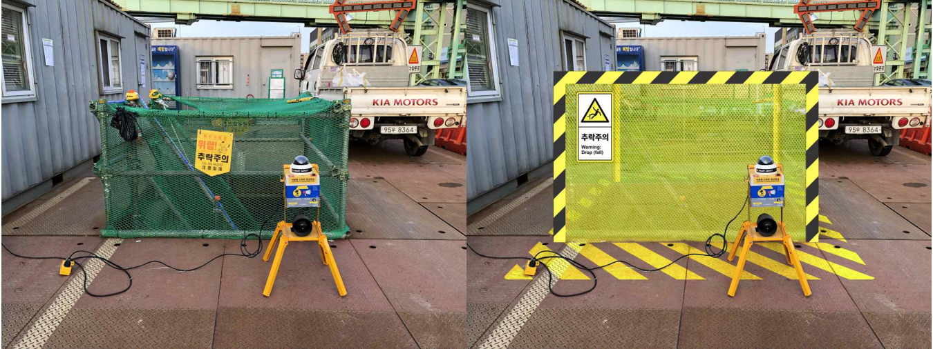
▲ 사고가 빈번한 출입구 및 수직동선의 주의를 강조하는 작업장 출입구 및 계단(좌:개선 전/ 우:개선 후)
