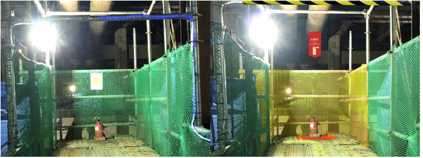
▲ 소화기 위치 안내를 돕는 상부 안내사인 부착 및 바닥조닝 (좌:개선 전/ 우:개선 후)
