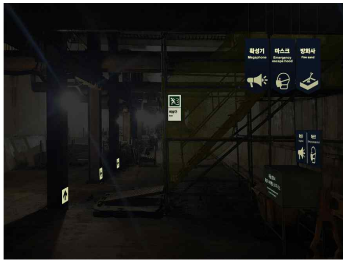
▲ 암전시에도 확인이 가능한 긴급대피설비(확성기, 마스크, 방화사) 위치안내사인(개선 후/ 암전시)
