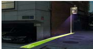
축광도로 활용한 출입구 유도표시('21)
