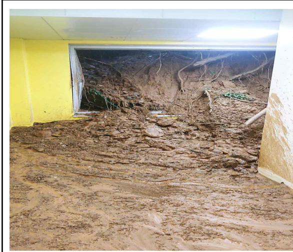
폭우로 인한 토사 유입
