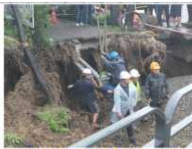
② 상수도관 파손 및 복구
