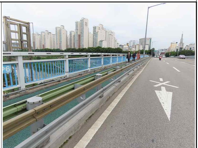
보도부 (난간, 가드레일) 설치전경
