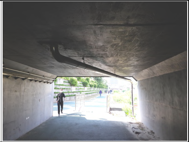
바닥판 전경 (BOX구간)
