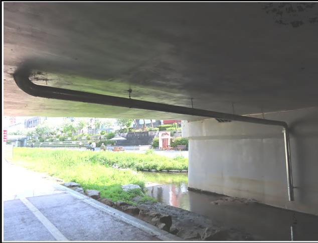
바닥판 전경 (RC-Slab구간)
