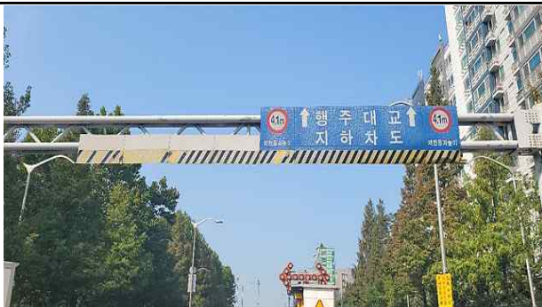
8 정비전(공항입구지하) 지하차도 진입차단시설 변색등
