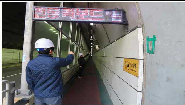
7 정비전(화곡터널) - 터널벽체등 보행로
