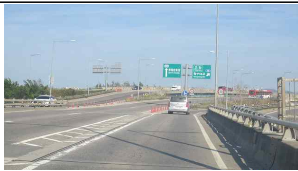
2 정비전(행주2교) - 교면포장 상태 등
