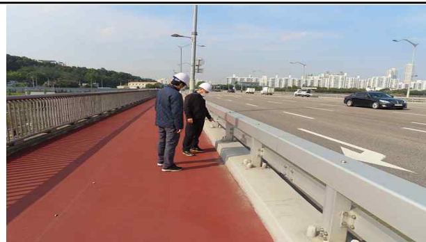
3 정비전(오금교) - 보행로 및 방호울타리
