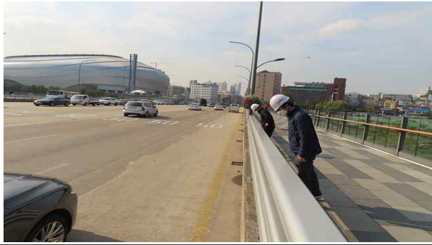
5 정비전(고척교) - 포장부 및 방호울타리
