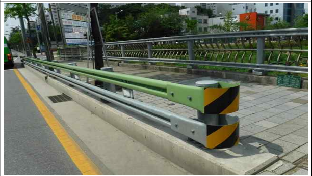
난간 및 연석 전경(차도부)
