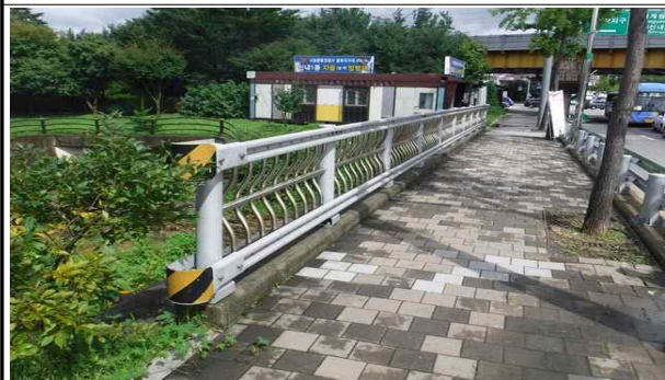
난간 및 연석 전경(보도부)
