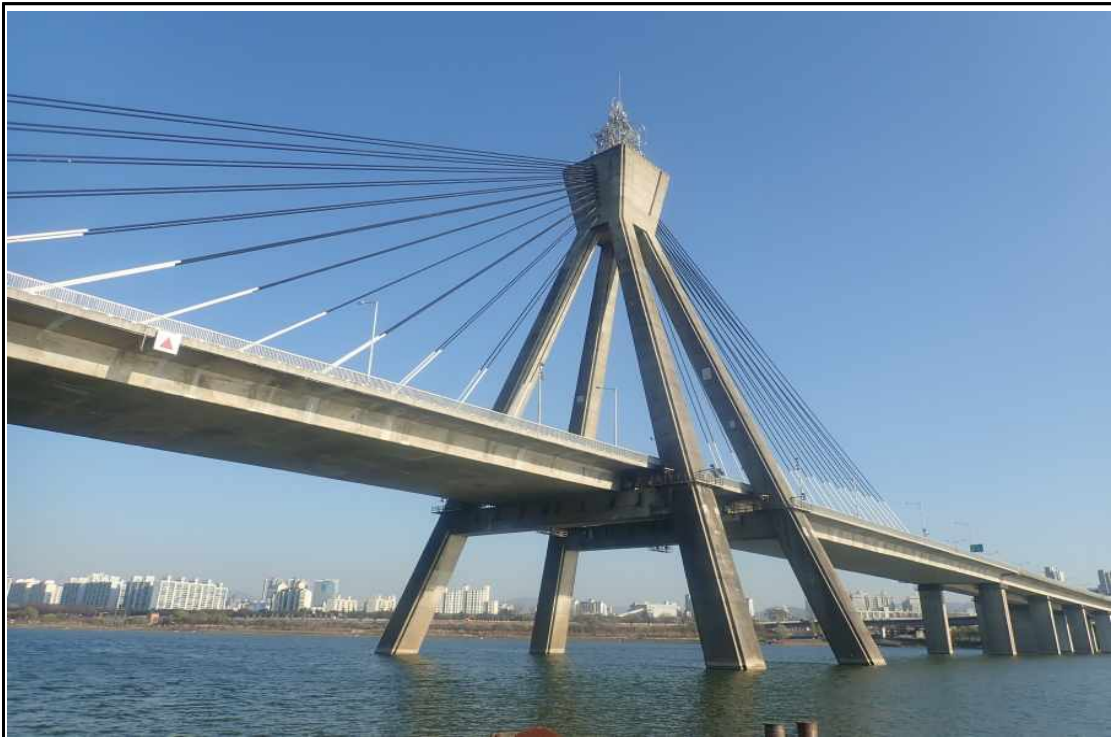
주탑 및 케이블 전경
