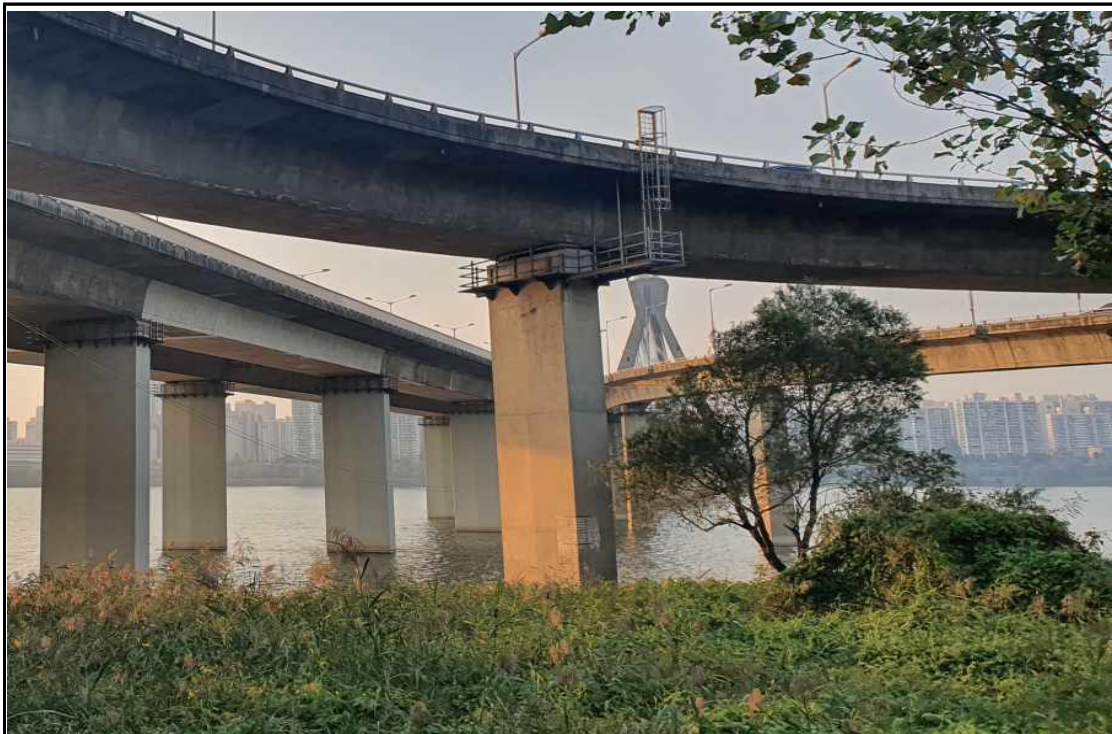
H램프교 하부 전경
