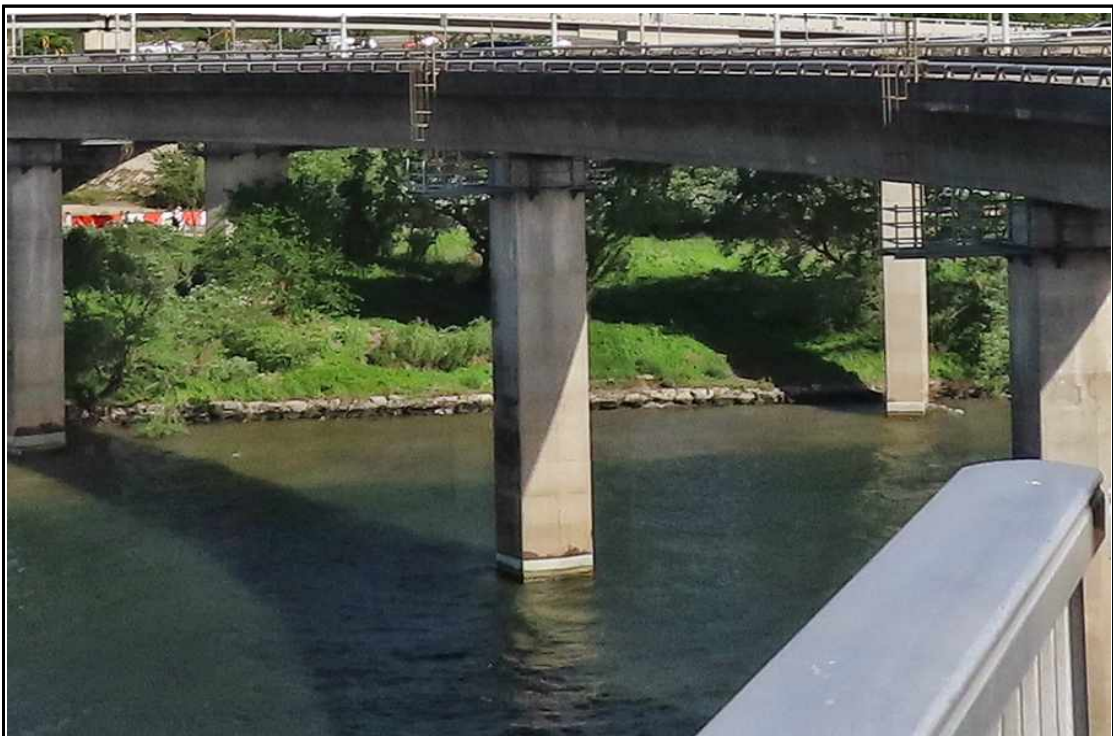
H램프교 하부 전경
