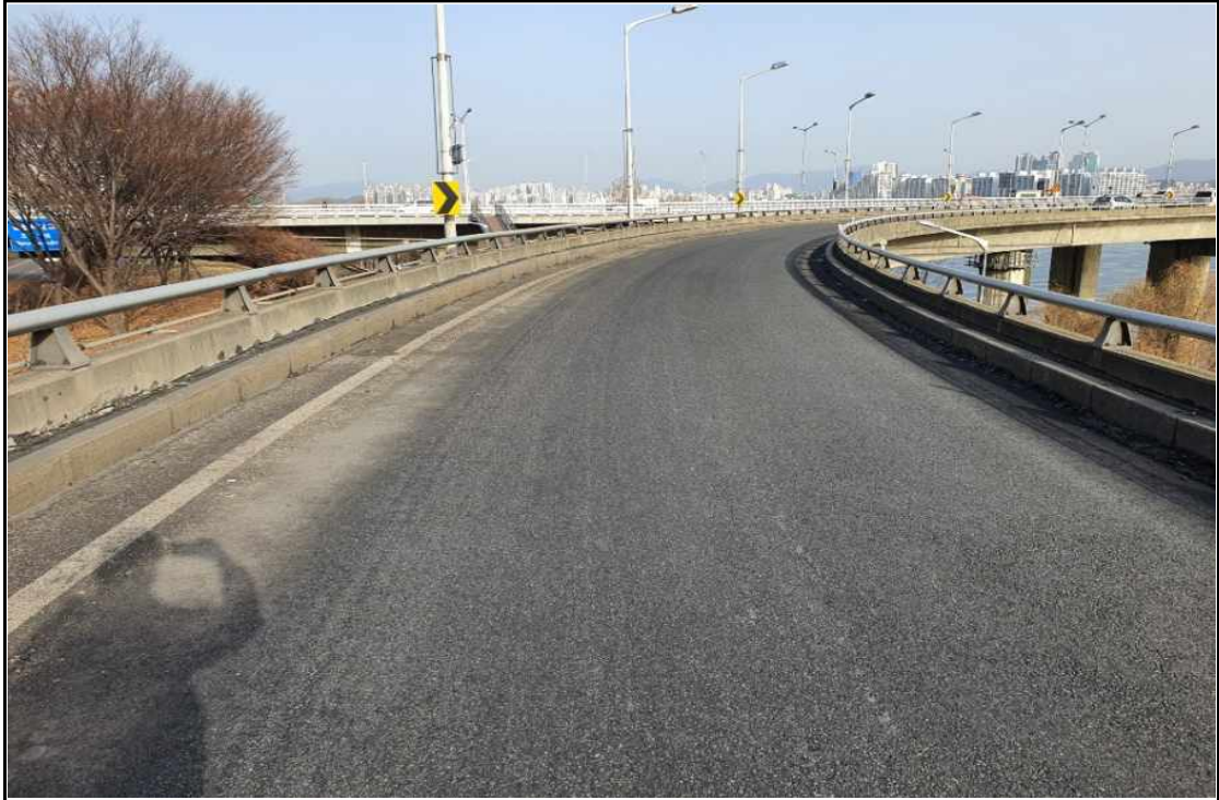
B램프교 상부 전경
