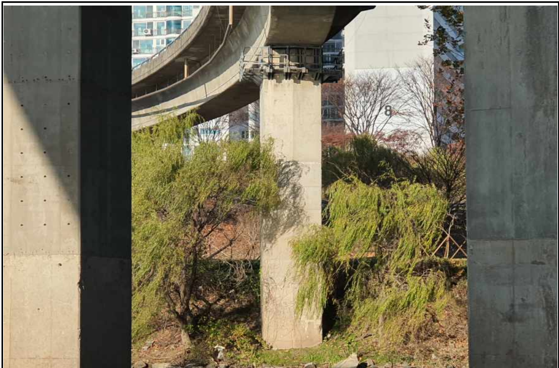
B램프교 하부 전경
