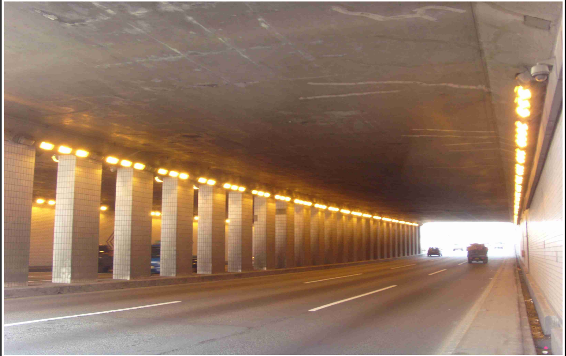
수서지하차도 내부 전경
