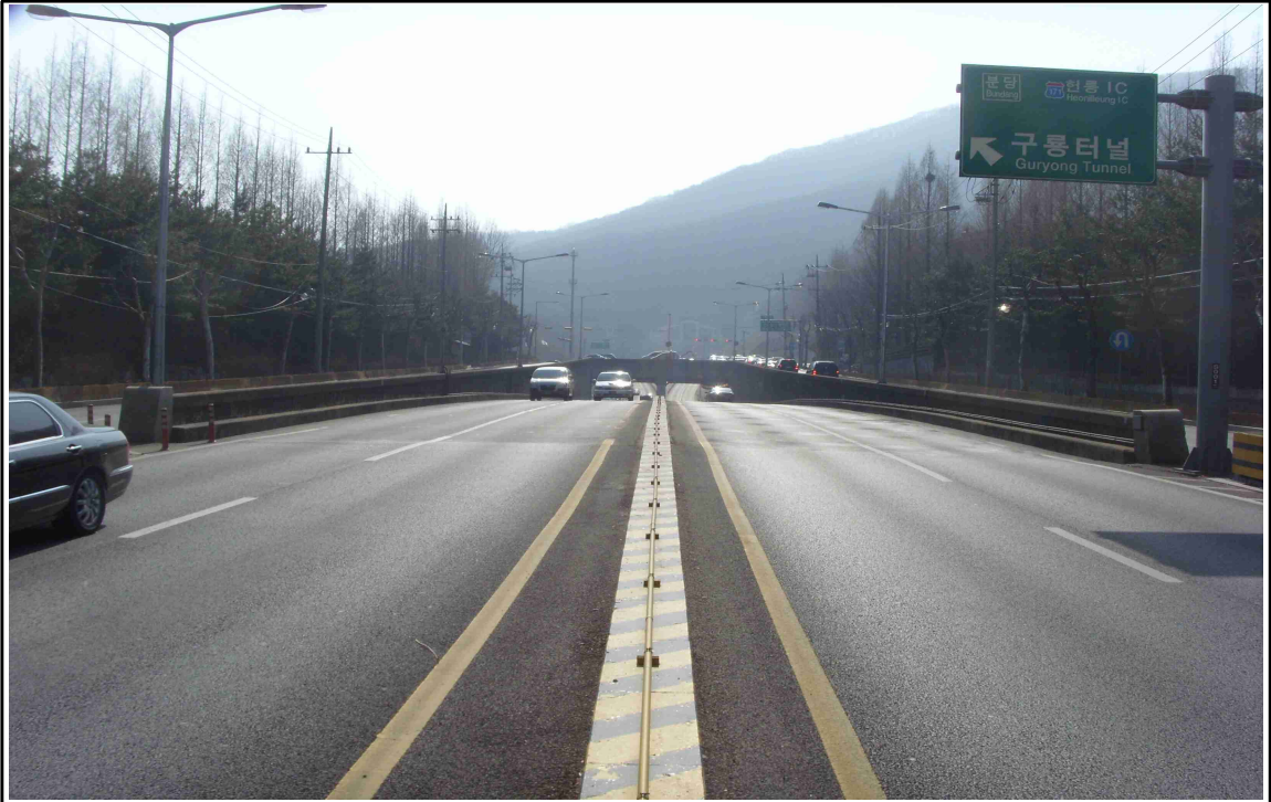
개포지하차도 외부 전경
