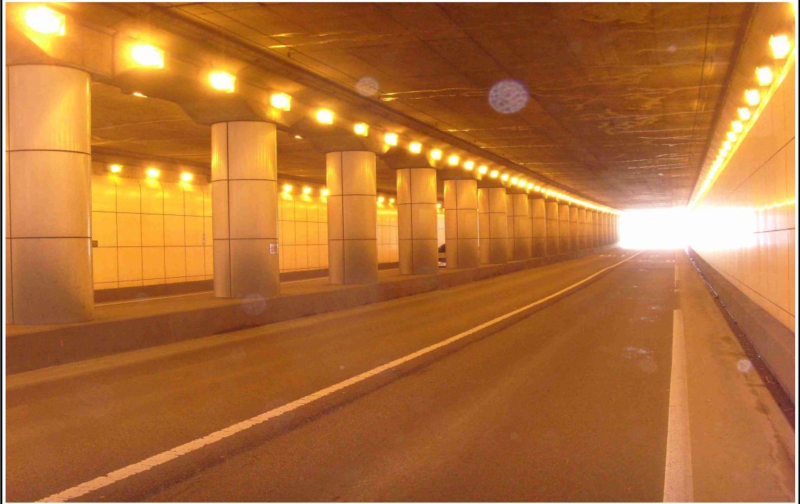
개포지하차도 내부 전경
