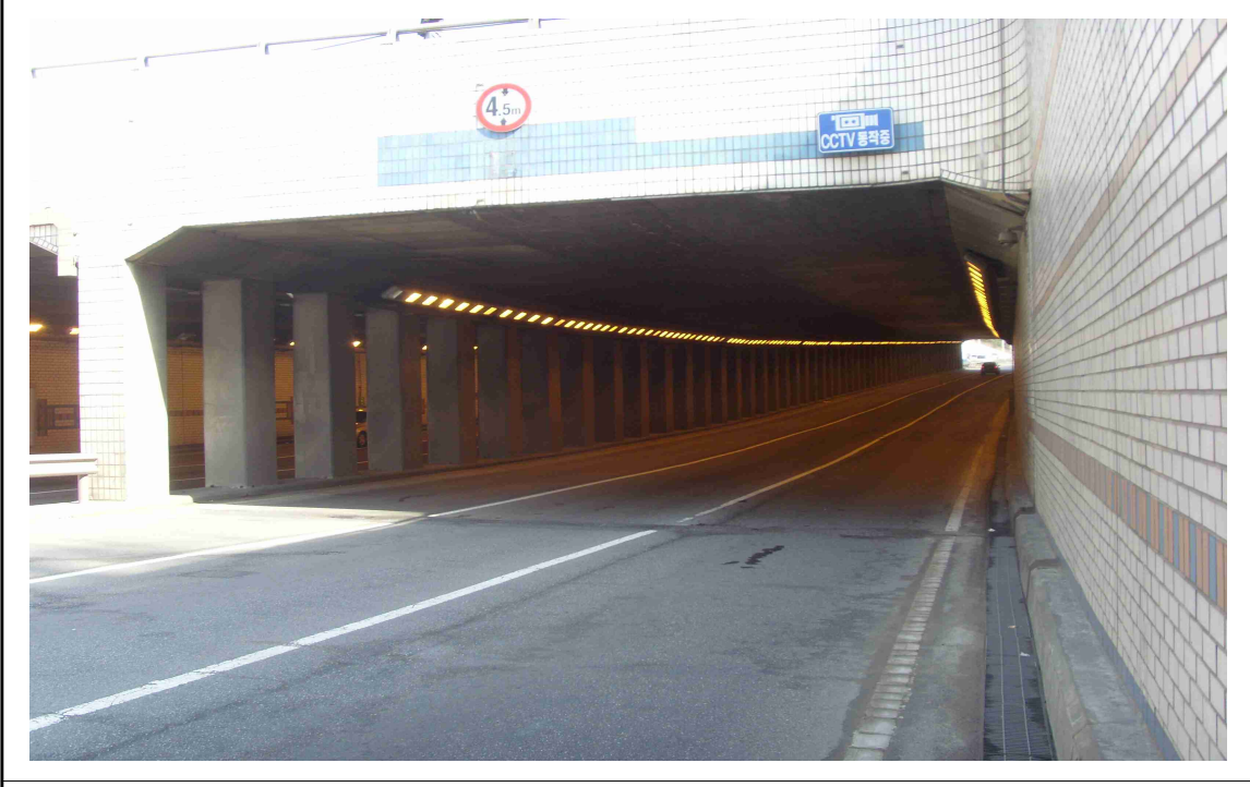
일원지하차도 내부 전경
