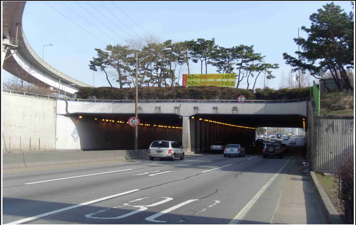
수서지하차도 외부 전경
