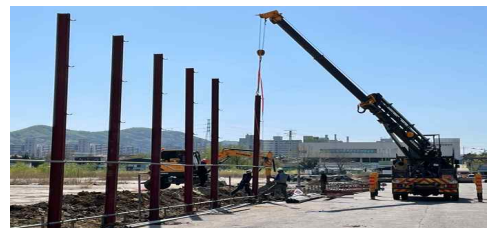
< 1공구 공사 진행상황 >
