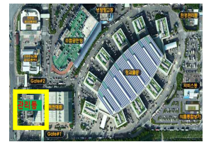
< 관리동 1층 설치 >
