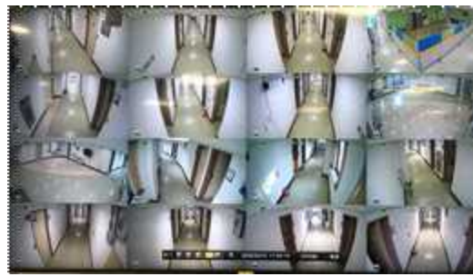
〈 환자 숙소 복도별 CCTV 설치 〉
