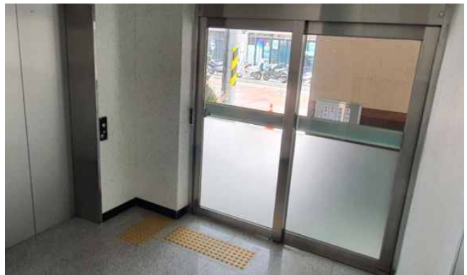
동출입구 현관 전경(내부)
