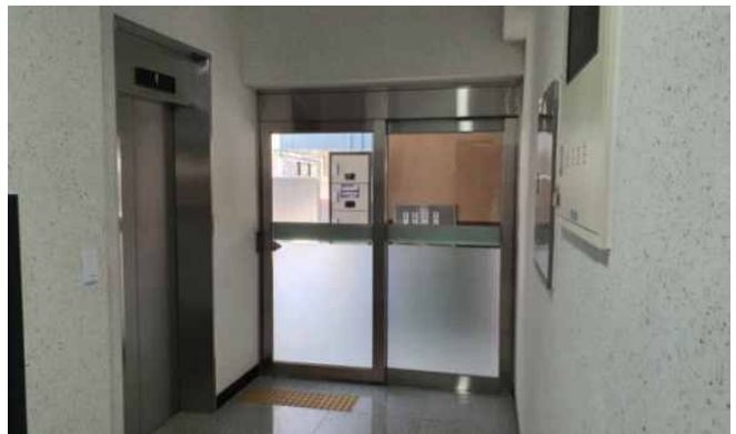
동출입구 현관 전경(내부)
