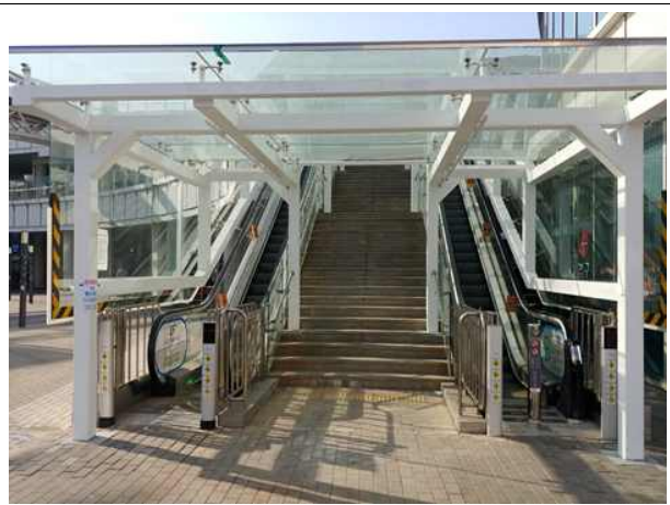
3관 앞 옥외 에스컬레이터 현장 사진
