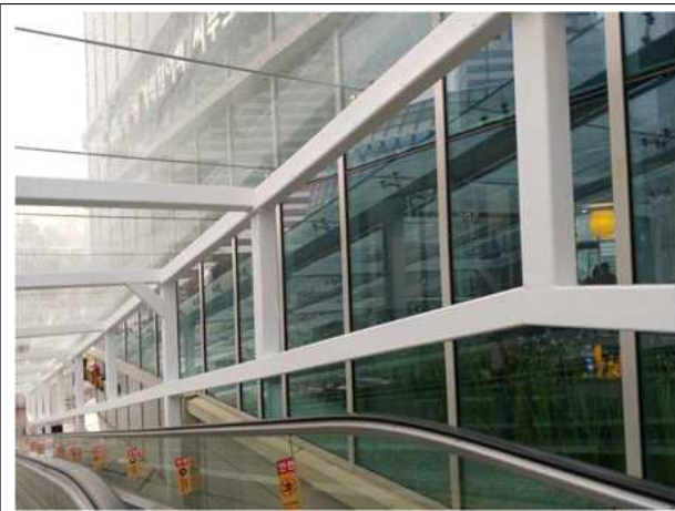
5관 앞 옥외 무빙워크 현장 사진
