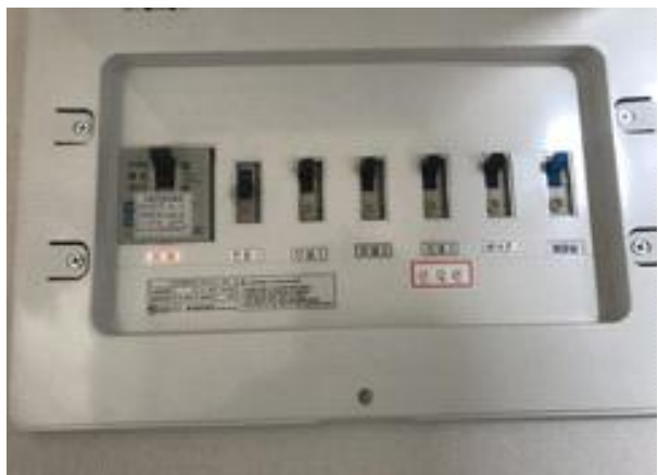
사진8-1. 세대 전기분전함 인덕션 차단기 표시
