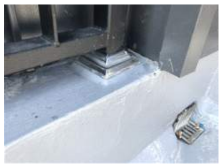
사진23-1. 평철 난간 양카 시공 및 베이스 하부 커버 설치 및 실리콘 시공
