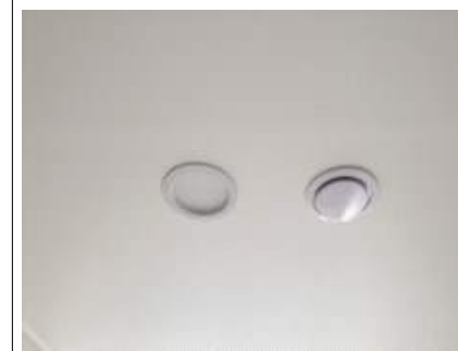
사진1-1. 501호 천정 도배 재시공
