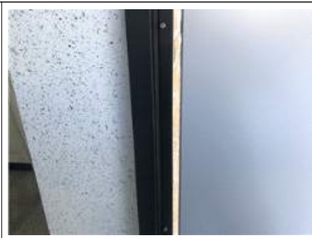
사진24-1. 옥탑 방화문 방화핀 시공
