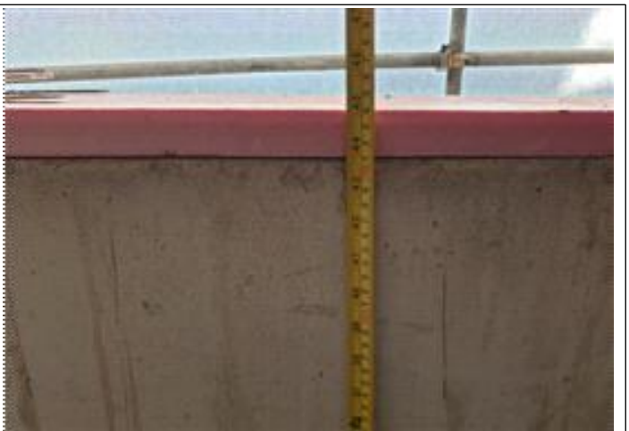
사진6. 계단실 창높이 h=1,200mm 이상 실측 h=1,150mm
