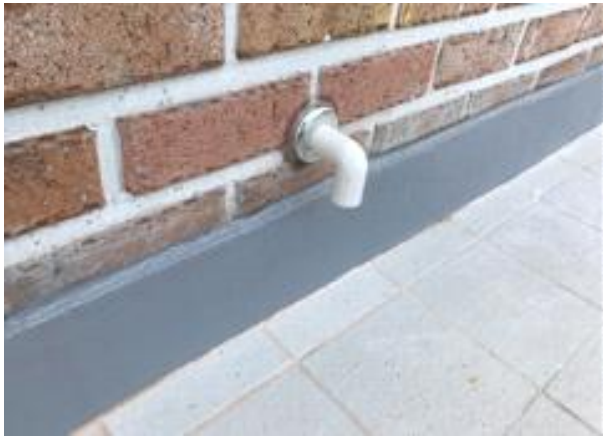
사진3. 에어컨 드레인 커버 설치
