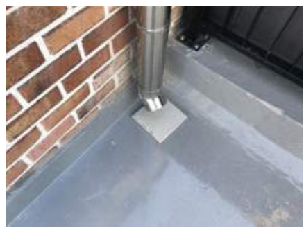
사진22-1. 옥상 선홍통 물받이석 시공
