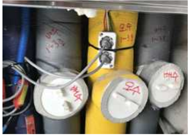
사진6-1. 1층 점검구 오,배수 라인 표시
