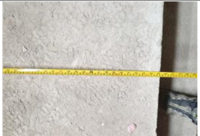
사진10. 계단 참 너비 1200mm 미확보 실측 1,150mm로서 마감과정에서 조정예정
