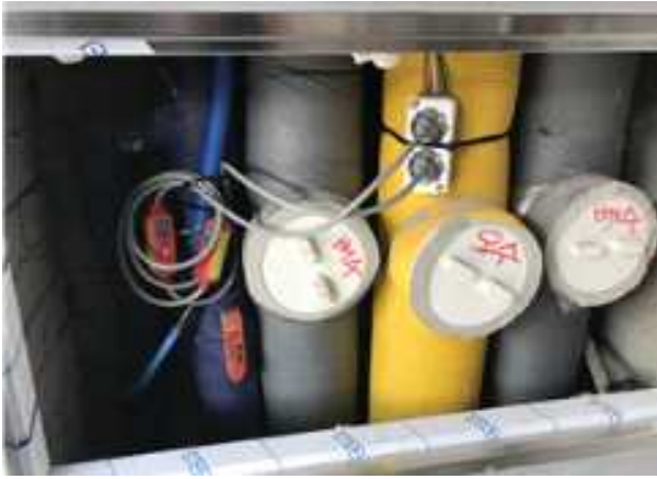
사진6. 1층 점검구 오,배수 라인 표시
