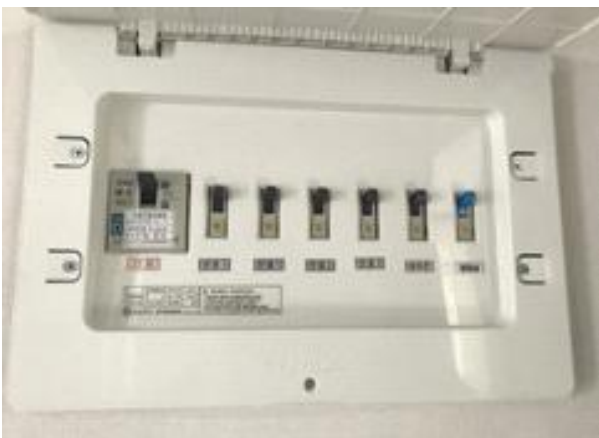
사진8. 세대 전기분전함 인덕션 차단기 표시
