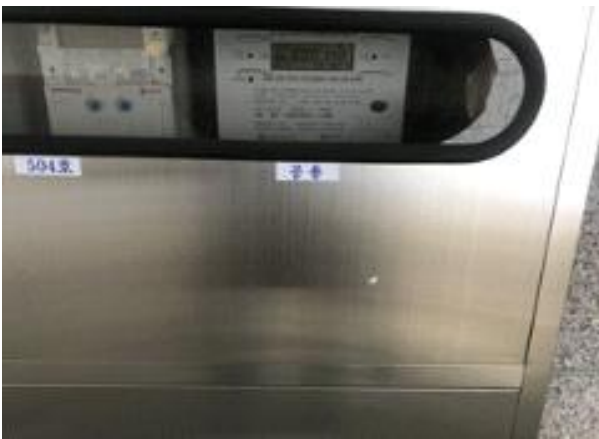
사진7. 1층 전기 검침함 조건표 누락
