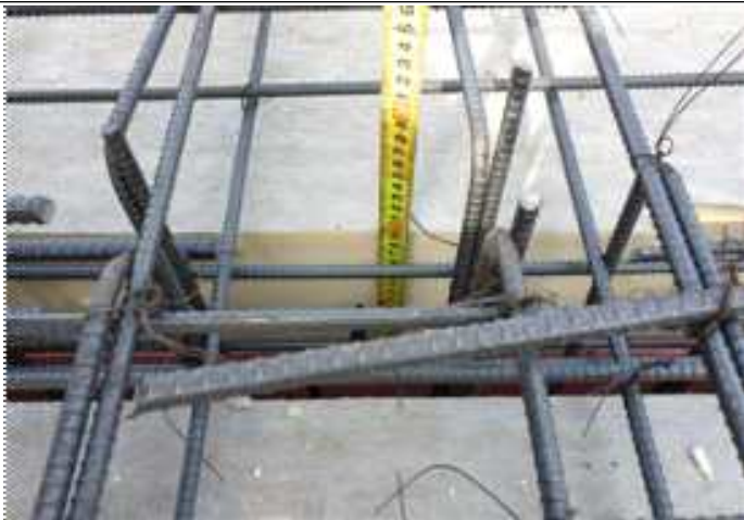
사진9. 최상층 단열재 경질 우레탄보드 190mm
