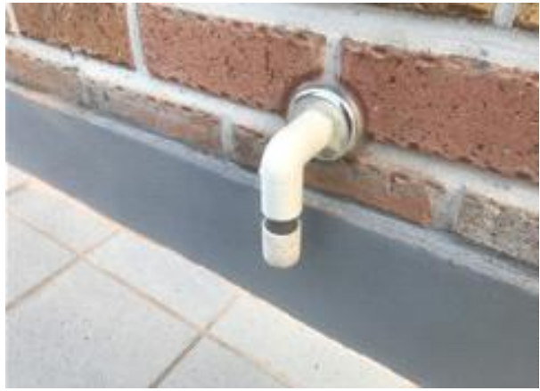
사진3-1. 에어컨 드레인 커버 설치
