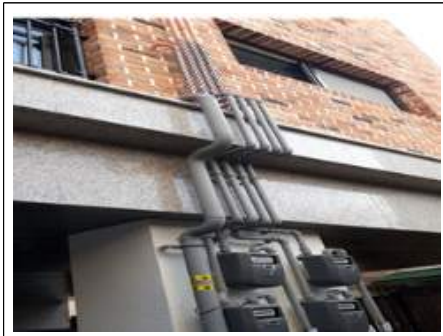
사진21. 도시가스 배관 가시철망 추가설치
