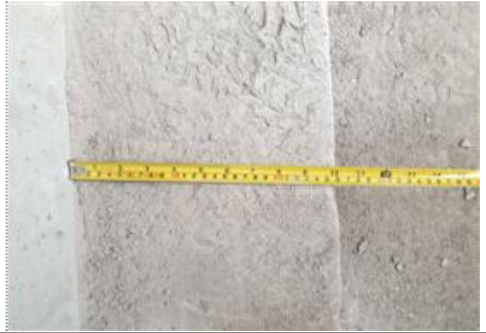
사진8. 계단 단너비 260mm확보 실측:260mm
