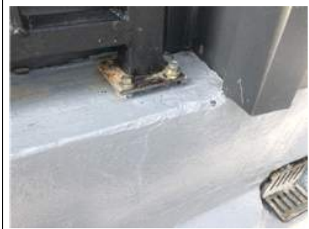
사진23. 평철 난간 양카 누락 및 베이스 하부 커버 설치 및 실리콘 시공
