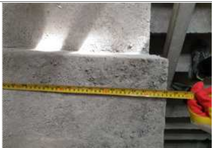
사진5. 계단유효폭 1,200mm확보 실측:1,250mm
