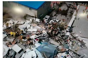
용산 건물 붕괴사고 (18.6.3)
